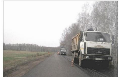
Ремонт дороги Останкино-Орлово
